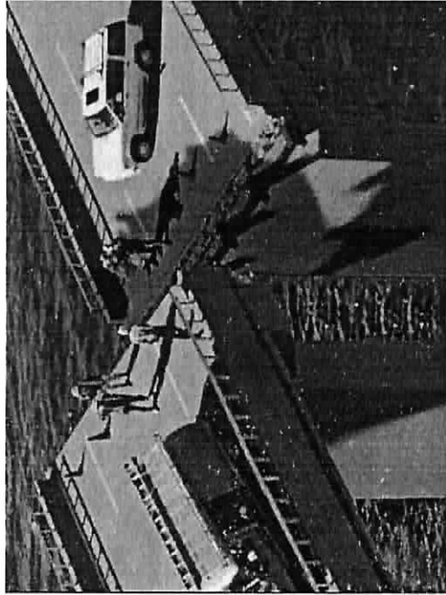
Imagem 5: Ilustração representando possíveis consequências de falhas de datum em etapas de projetos de engenharia. Fonte: Adaptado de Google Images - https://www.google.com/search?q=misaligned+bridge
