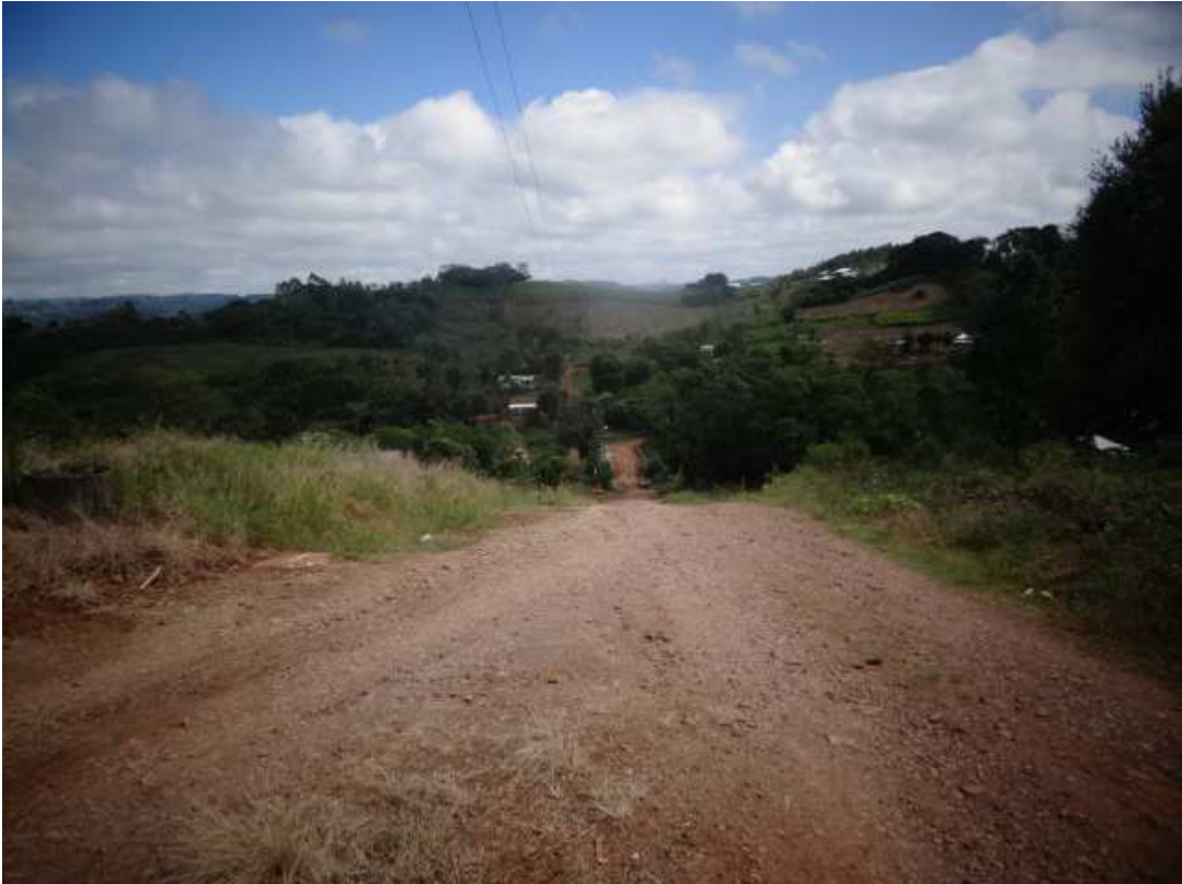
Foto 03 – Rua Querino Scaravonatti, vista da Rua Gramado em direção a Rua Gastão Benetti.
