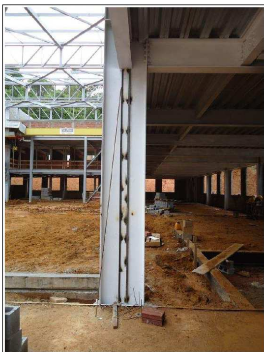
Figura 03 - Foto demonstrativa das cantoneiras de aço soldadas nos pilares metálicos existentes.
