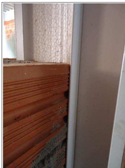
Figura 04 - Foto demonstrativa do sistema de encaixe da alvenaria, formado por cantoneiras de aço e EPS.
