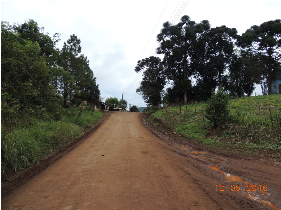
Foto 03 – Rodovia Municipal – Rua “A”, vista da estaca 14 em direção à estaca 13.
