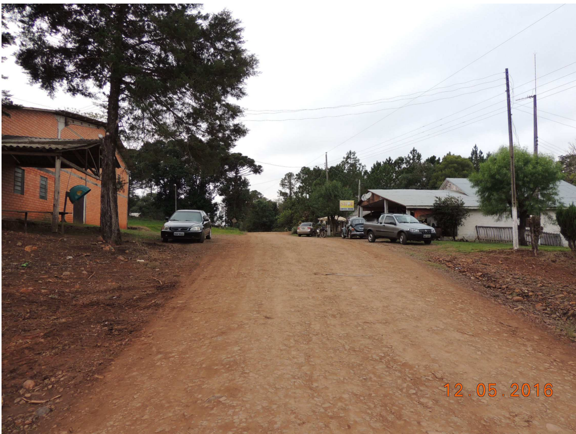
Foto 16 – Rodovia Municipal – Rua “A”, vista da estaca 08 em direção à estaca 09.
