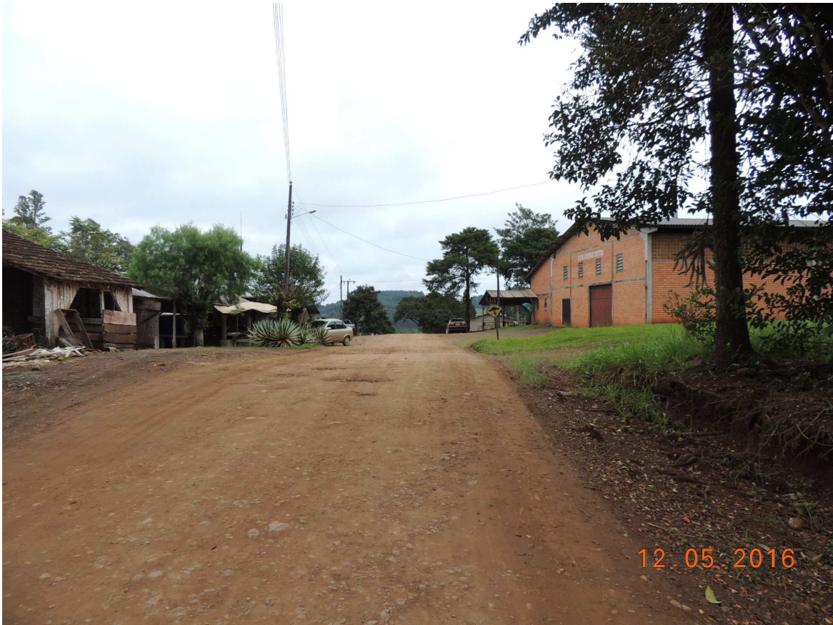
Foto 07 – Rodovia Municipal – Rua “A”, vista da estaca 12 em direção à estaca 11.
