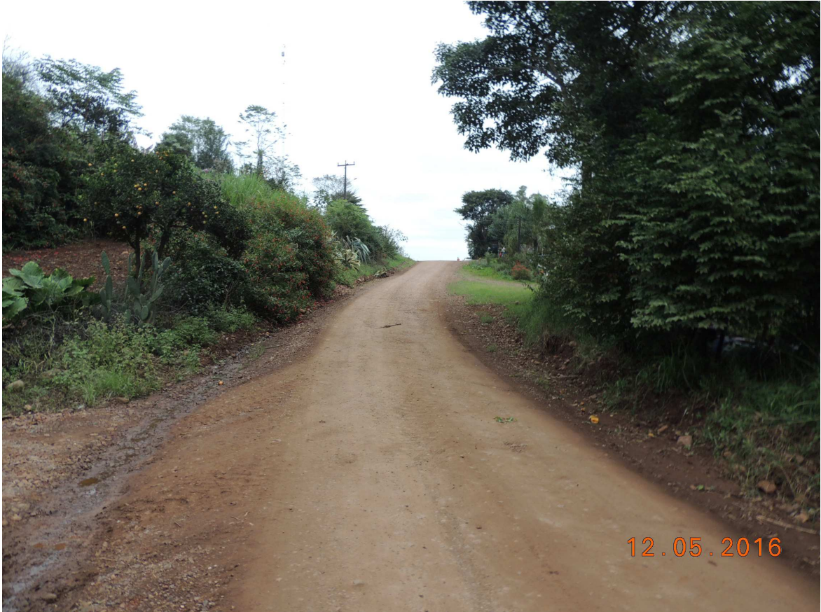
Foto 32 – Rodovia Municipal – Rua “A”, vista da estaca 01 em direção à estaca 02.
