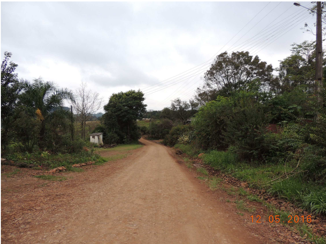
Foto 23 – Rodovia Municipal – Rua “A”, vista da estaca 05 em direção à estaca 04.
