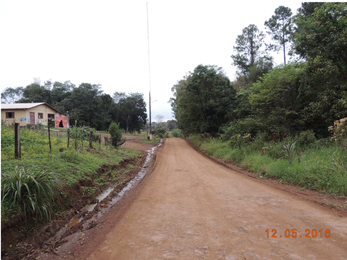
Foto 08 – Rodovia Municipal – Rua “A”, vista da estaca 12 em direção à estaca 13.
