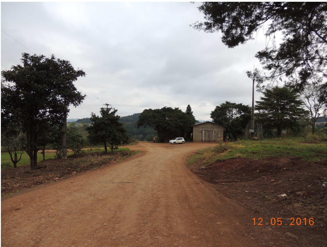
Foto 13 – Rodovia Municipal – Rua “A”, vista da estaca 09 em direção à estaca 08.
