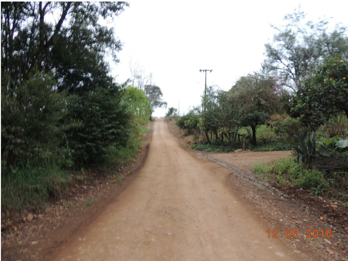
Foto 29 – Rodovia Municipal – Rua “A”, vista da estaca 02 em direção à estaca 01.
