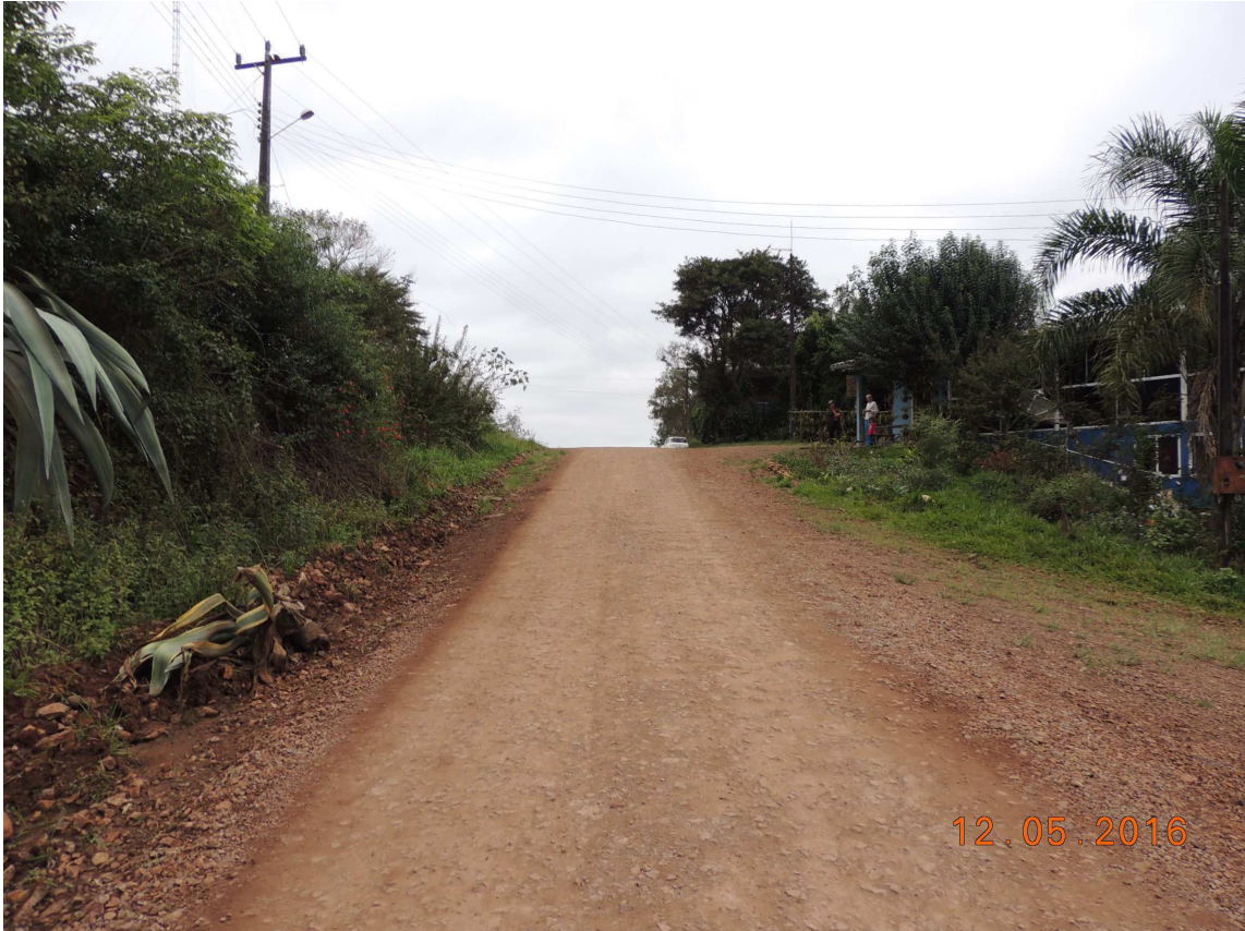
Foto 28 – Rodovia Municipal – Rua “A”, vista da estaca 03 em direção à estaca 04.
