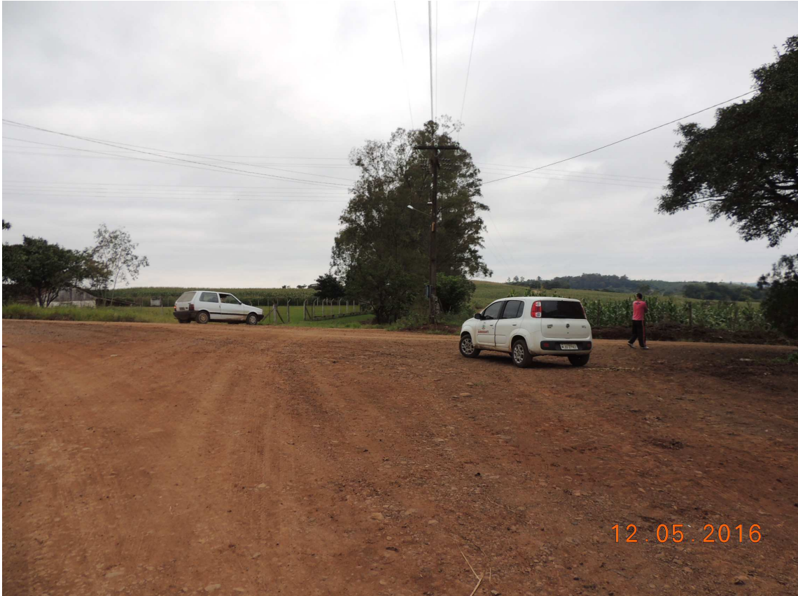
Foto 22 – Rodovia Municipal – Rua “A”, vista da estaca 06 em direção à estaca 07.
