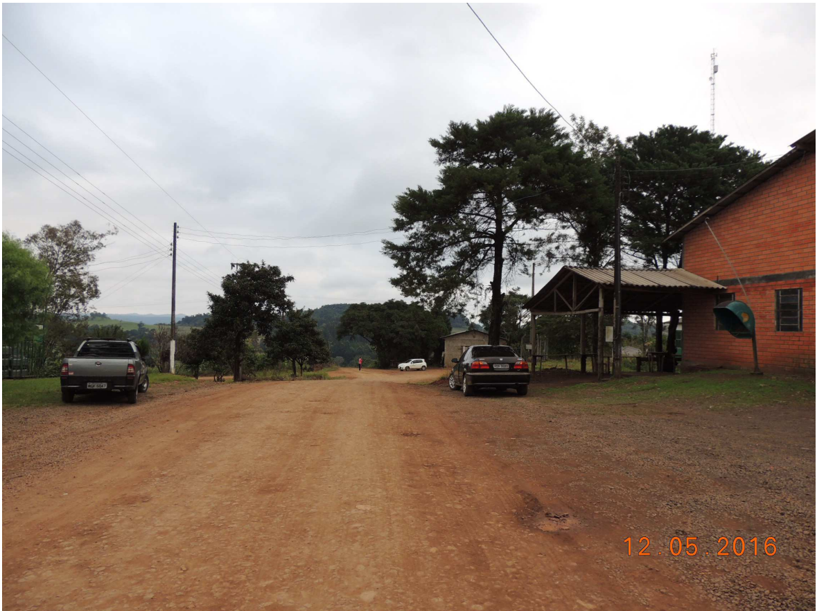
Foto 11 – Rodovia Municipal – Rua “A”, vista da estaca 10 em direção à estaca 09.
