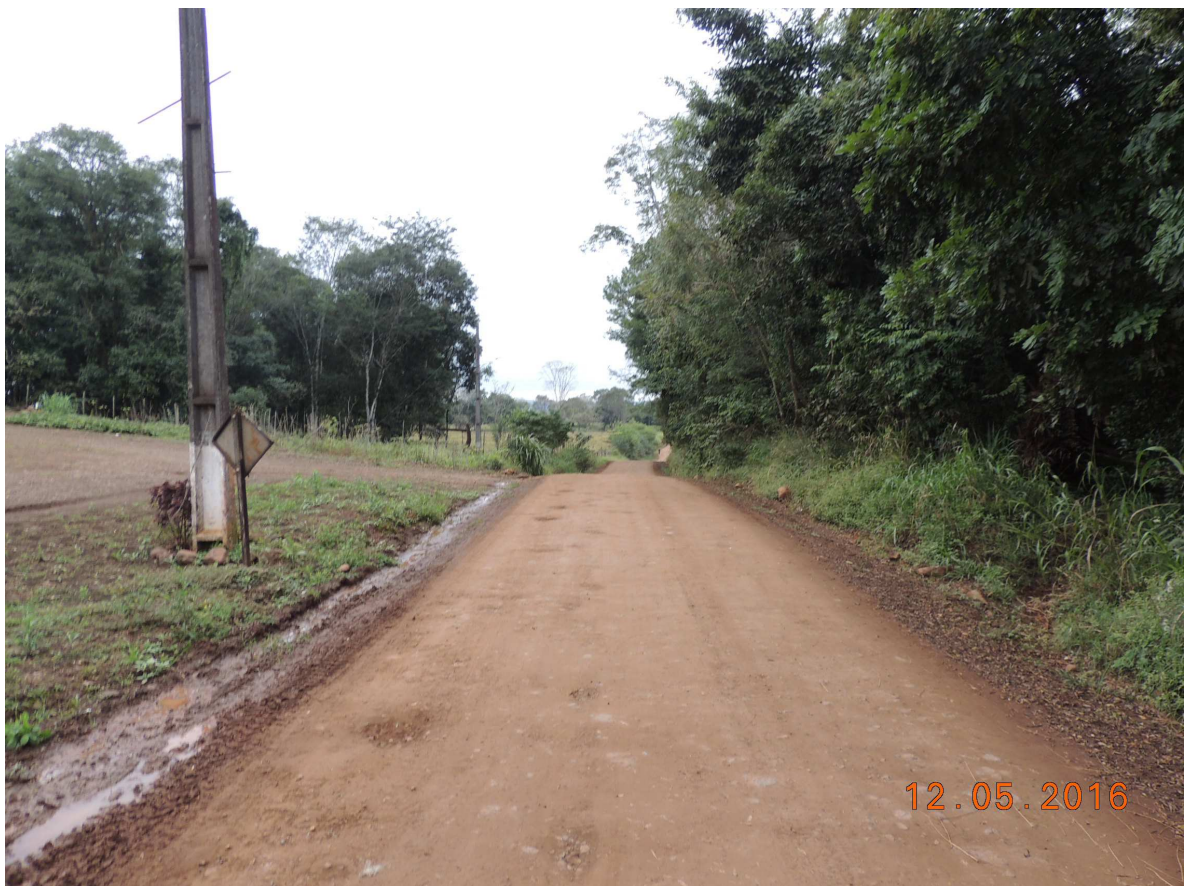
Foto 04 – Rodovia Municipal – Rua “A”, vista da estaca 14 em direção a estaca 15.
