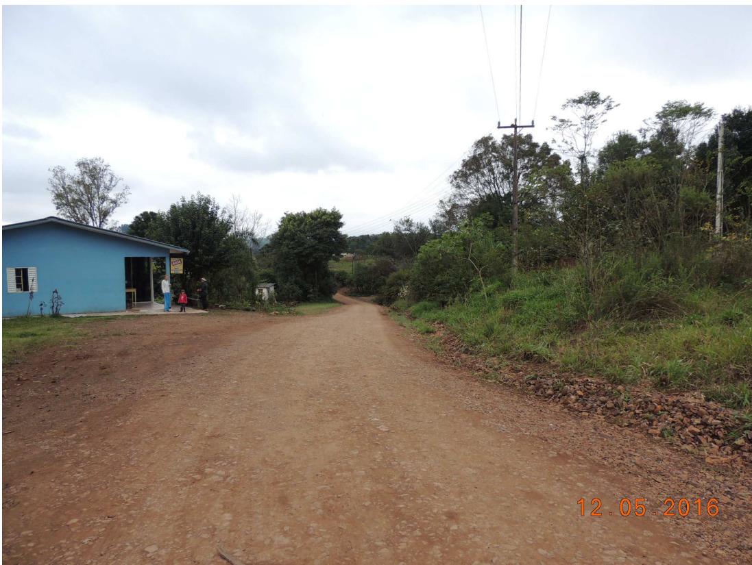
Foto 21 – Rodovia Municipal – Rua “A”, vista da estaca 06 em direção à estaca 05.
