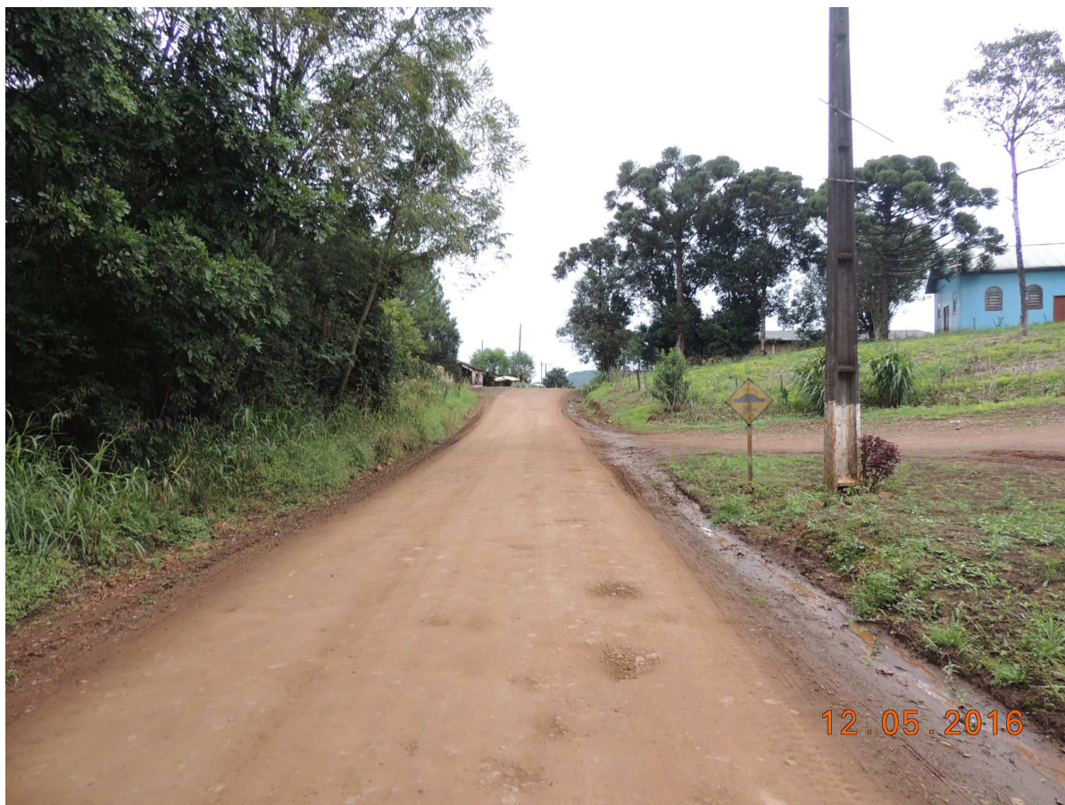
Foto 01 – Rodovia Municipal – Rua “A”, vista da estaca 15 em direção à estaca 14.
