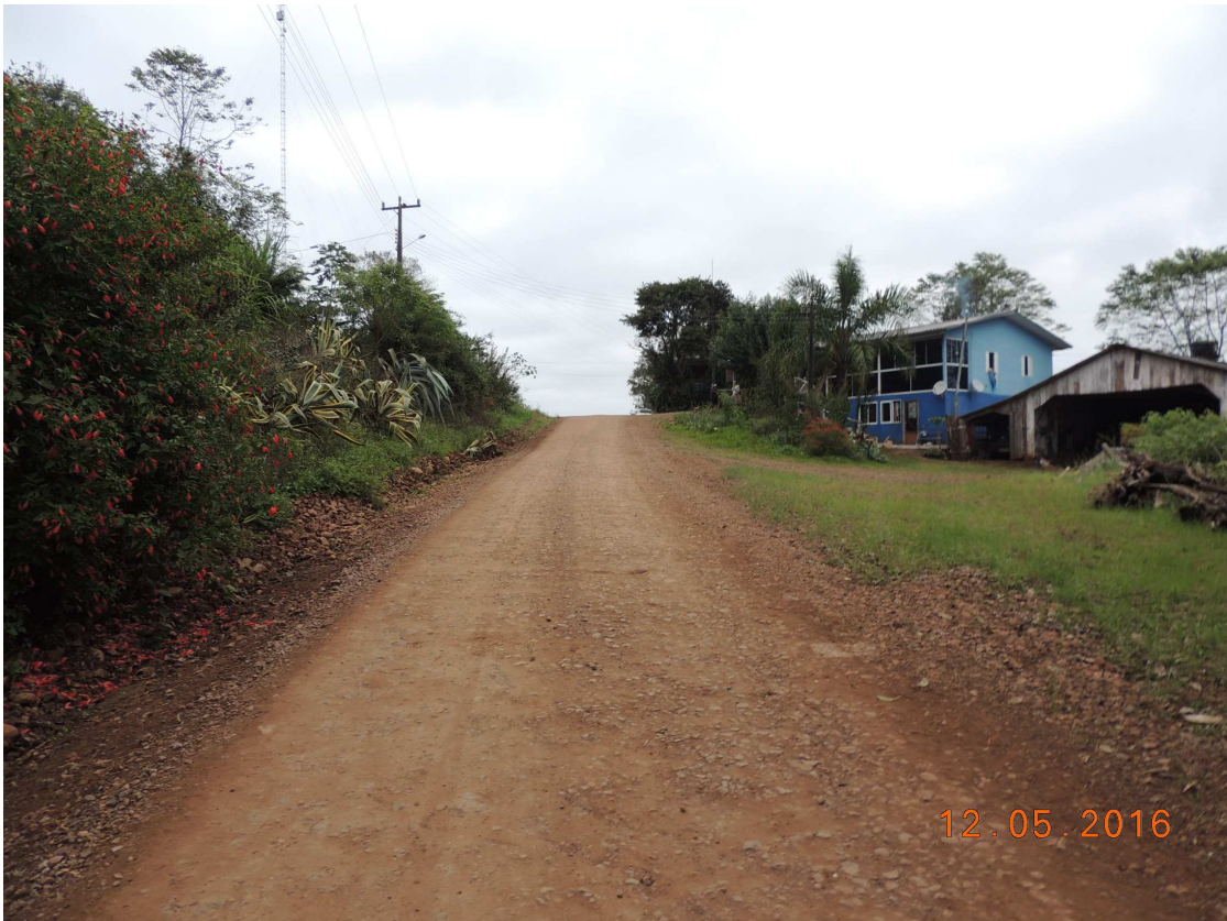
Foto 30 – Rodovia Municipal – Rua “A”, vista da estaca 02 em direção à estaca 03.
