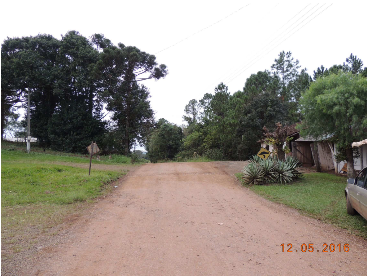
Foto 12 – Rodovia Municipal – Rua “A”, vista da estaca 10 em direção à estaca 11.
