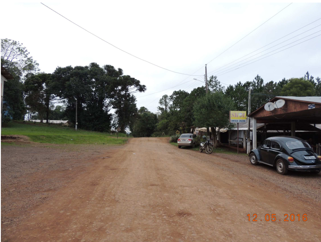
Foto 14 – Rodovia Municipal – Rua “A”, vista da estaca 09 em direção à estaca 10.
