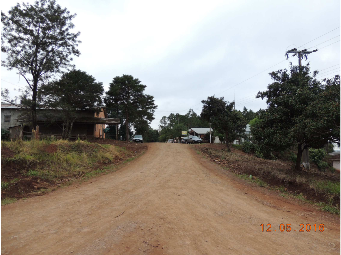
Foto 18 – Rodovia Municipal – Rua “A”, vista da estaca 07 em direção à estaca 08.
