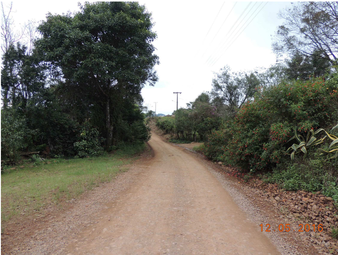
Foto 27 – Rodovia Municipal – Rua “A”, vista da estaca 03 em direção à estaca 02.
