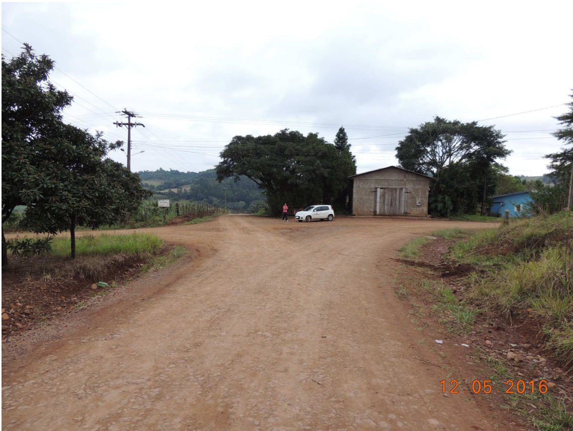
Foto 15 – Rodovia Municipal – Rua “A”, vista da estaca 08 em direção à estaca 07.
