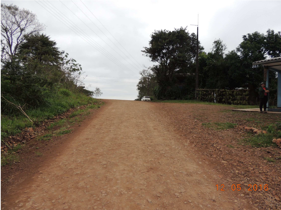
Foto 26 – Rodovia Municipal – Rua “A”, vista da estaca 04 em direção à estaca 05.
