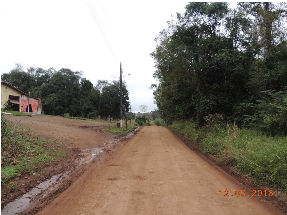
Foto 06 – Rodovia Municipal – Rua “A”, vista da estaca 13 em direção a estaca 14.
