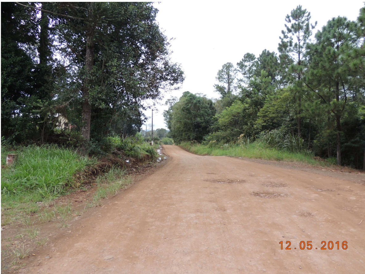
Foto 10 – Rodovia Municipal – Rua “A”, vista da estaca 11 em direção à estaca 12.
