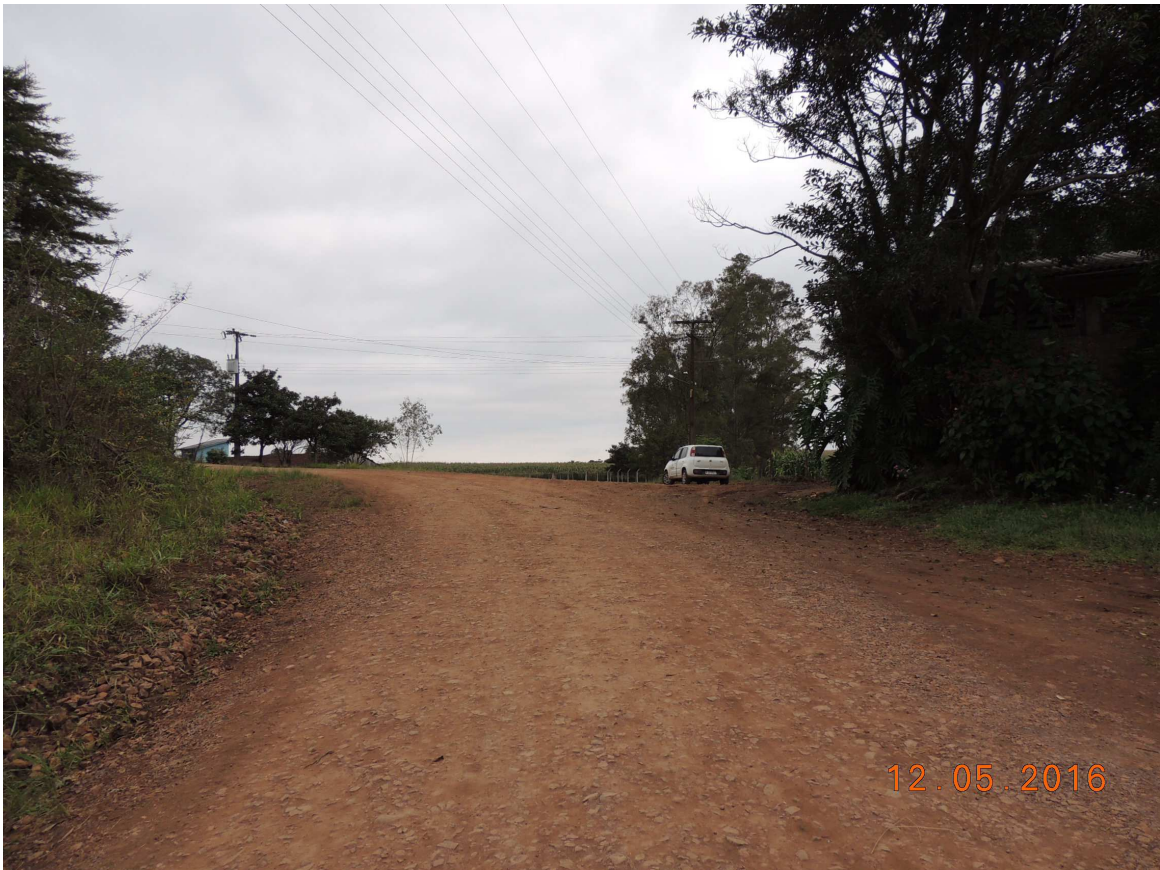
Foto 24 – Rodovia Municipal – Rua “A”, vista da estaca 05 em direção à estaca 06.
