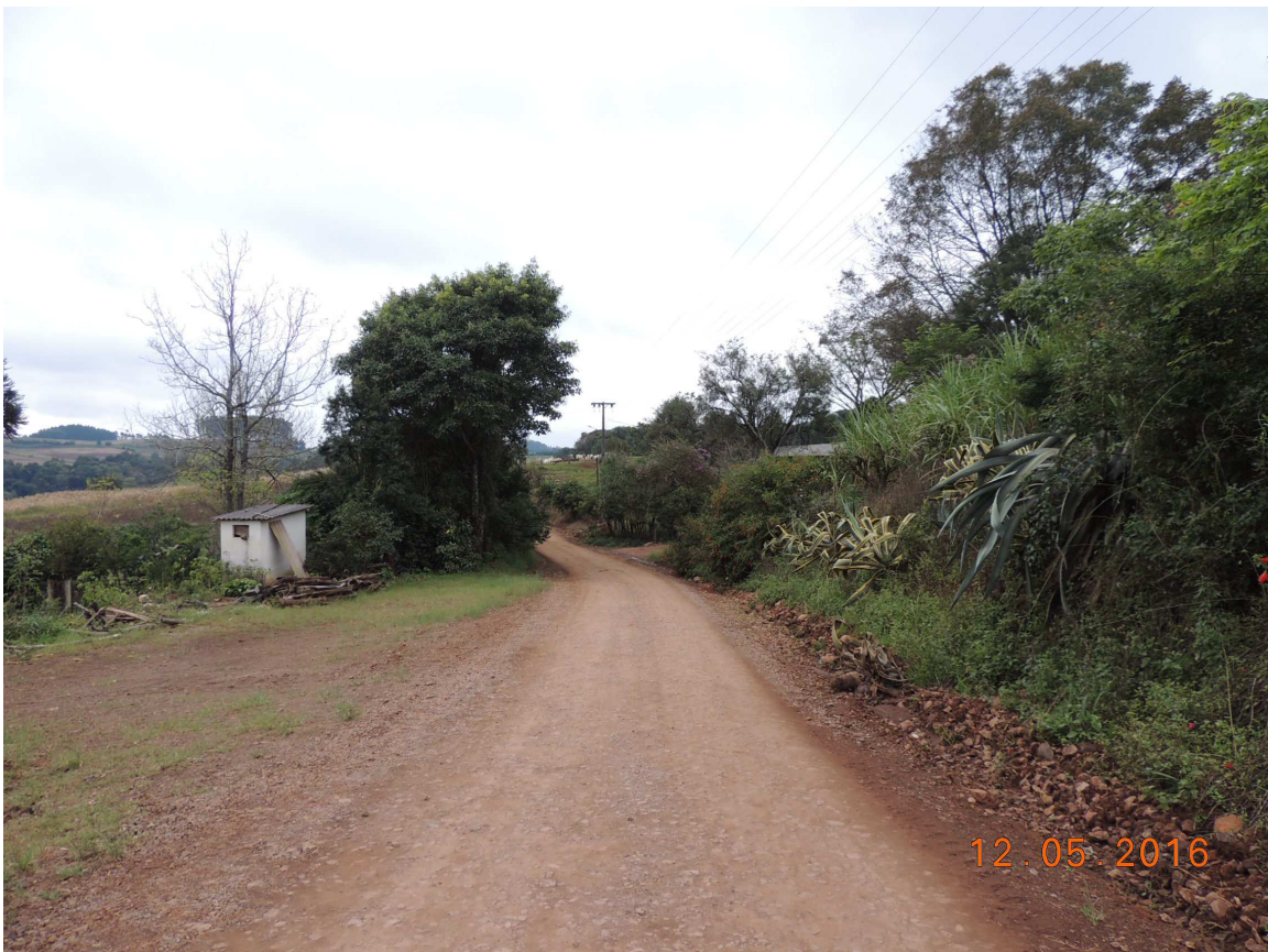
Foto 25 – Rodovia Municipal – Rua “A”, vista da estaca 04 em direção à estaca 03.
