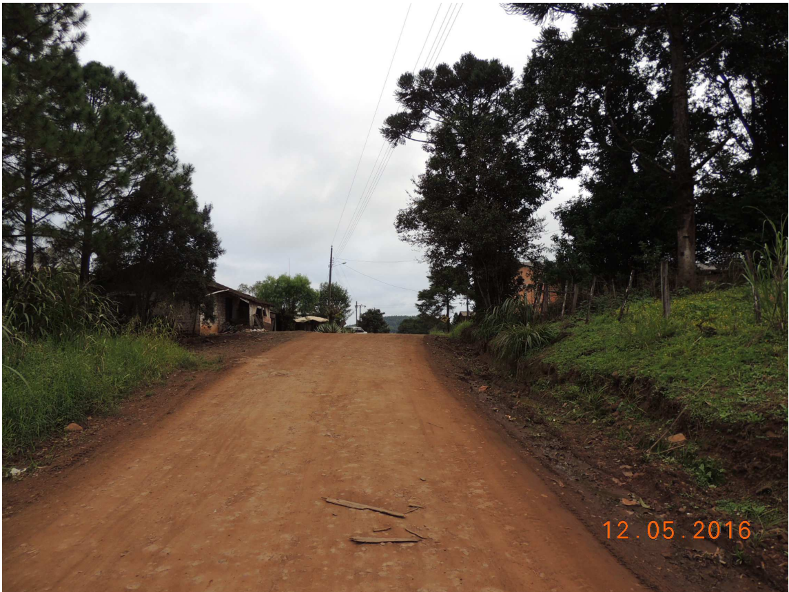
Foto 05 – Rodovia Municipal – Rua “A”, vista da estaca 13 em direção à estaca 12.
