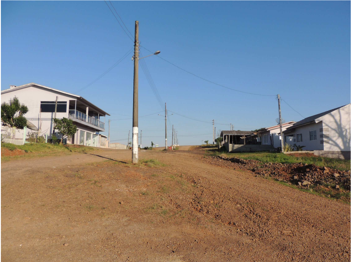
Foto 02 - Trecho da Rua 1º de Maio vista da Rua João B. Bataglin em direção à Avenida Santo Antônio.
